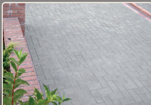
kifugázott kész kőburkolat
